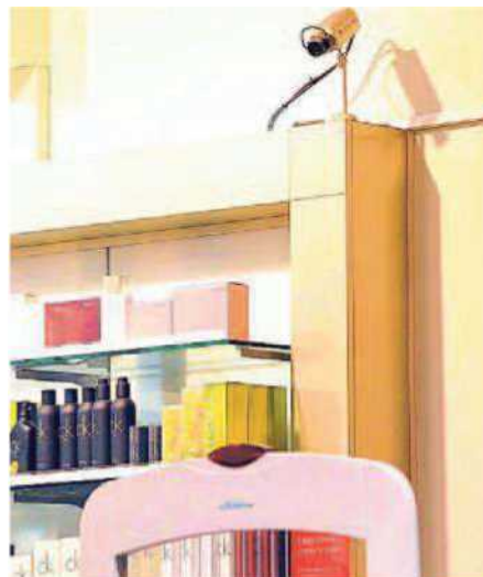
Un impianto di videosorveglianza
